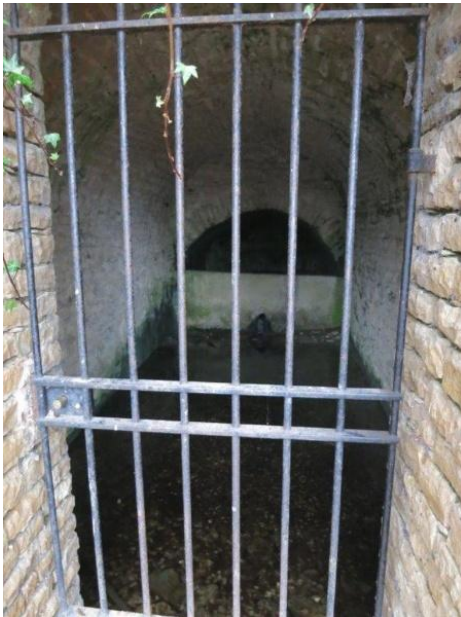
Intérieur de la source avec ses deux bassins. (Cliché Sigrid Pavèse).
